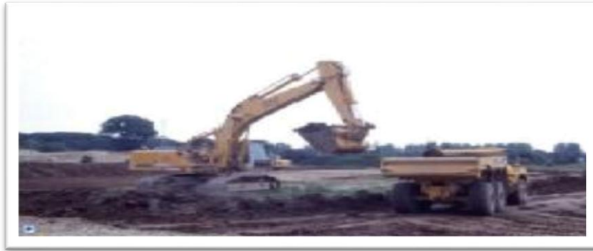
Figure II.2 : Décapage des terres arables en vue du futur réaménagement de la carrière
